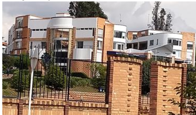
Figura 8 Estructura Física Edificio Giordano Bruno
