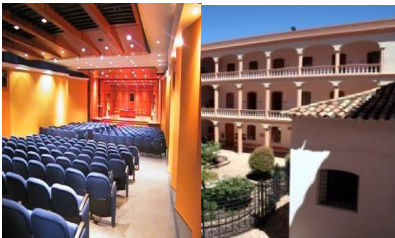
Figura 6 Infraestructura Física Campus Centro Histórico de la Universidad Santo Tomás Tunja.
