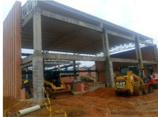
**DESCRIPCION:** Modulo 3A con el 100% de cimentación, estructura y cubierta y 40% de mampostería proceso en ejecución.
