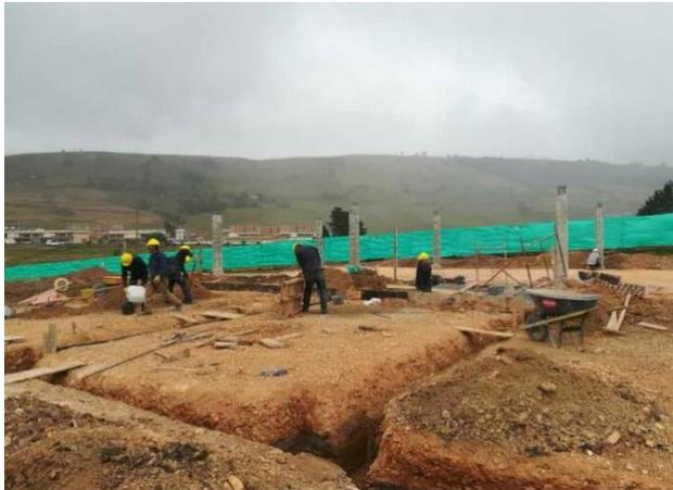
**DESCRIPCION:** Proceso de excavación de cimentación de los módulos y replanteo.
