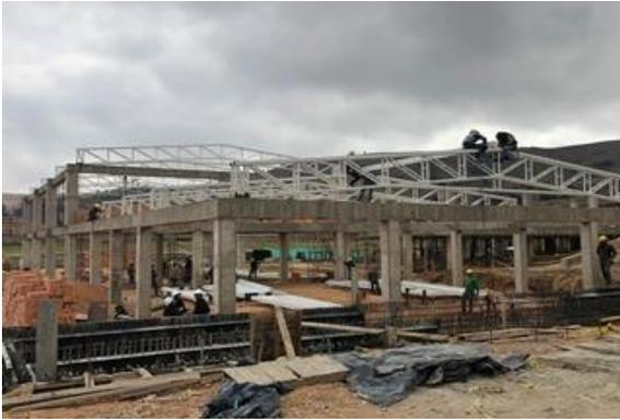
**DESCRIPCION:** Proceso de estructura finalizada del 100% de ejecución , instalación de cerchas para cubierta de los módulos del colegio y parque gran colombiano
